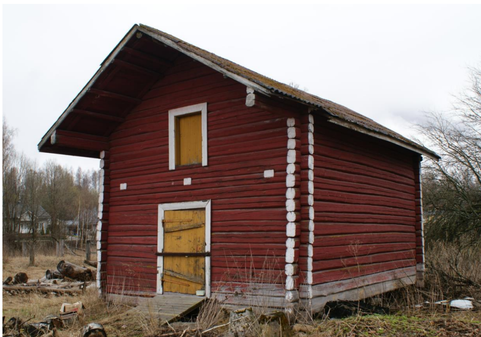
Kuva: Kaksikerroksinen, pitkänurkkainen, nurkkakiville perustettu aittarakennus on 1800-luvulta. Rakennus sijaitsee pihatien reunassa, mies- ja talouspihan ulkopuolella. Kate on aaltolevyä. Etelän- ja lännenpuoleiset seinät ovat haalistuneet ja ravistuneet (seinähirret ja nurkkasalvosten päät), myös kattolevyjä on irronnut.
