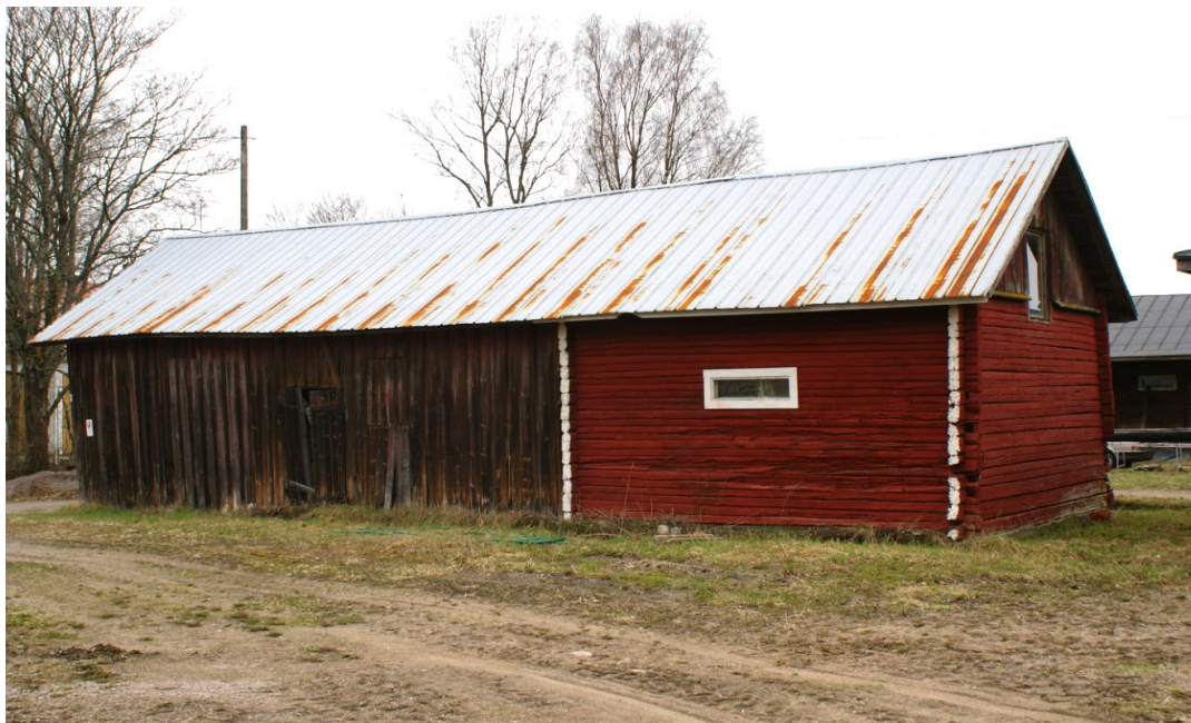
Kuva: Kaksiosainen, hirsi- ja lautarunkoinen, nurkkakiville perustettu puuvaja navetan vieressä. Peltikatto.
