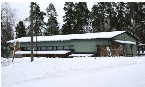
Kuva: Pihapiirissä sijaitseva liikuntasalirakennus on rakennettu 1990-luvulla. Puurunkoisessa rakennuksessa on loiva harjakatto, yhtenäinen vaakalautavuoraus ja betonisokkeli.
