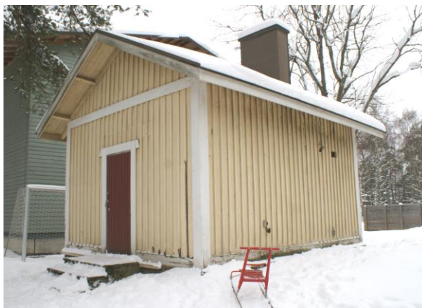
Kuva: Saunarakennus lienee tehty vanhimman koulurakennuksen kanssa samoihin aikoihin. Hirsirunko on verhoiltu rimalaudoituksella levein jalka-, nurkka- ja kerroslistoin. Kapeat ja korkeat ikkunat ovat kuusiruutuiset (nyt suojattu levyllä). Sisäänkäynti on päädyssä ja ovi pystypaneloitu, vesikate on saumattua pelti.
